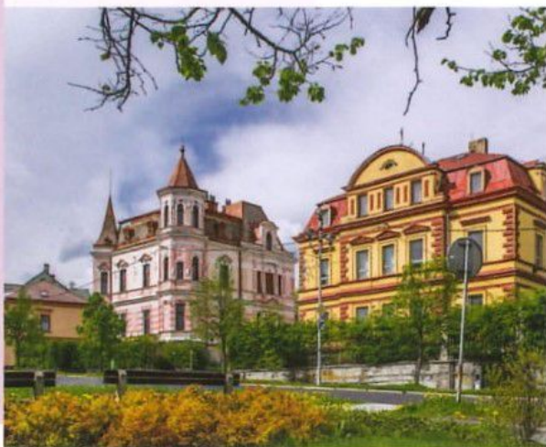
Vila ašského továrníka Alberta Kirchhoffa a vila Maxe Eisenschimla / Vila von den Fabrikant Albert Kirchoff und Vila von den Max Eisenschiml
